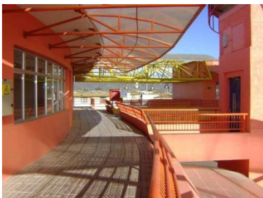
Escuela Cancha Rayada, Ovalle 2009
