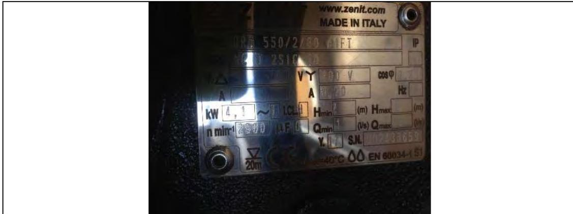
Fotografía N° 31 – 10/04/2018: Bombas zenit DRE 550/2/65/A1FT, de la planta de elevadora N° 2 cuenta con una potencia de 4,1 KW.
